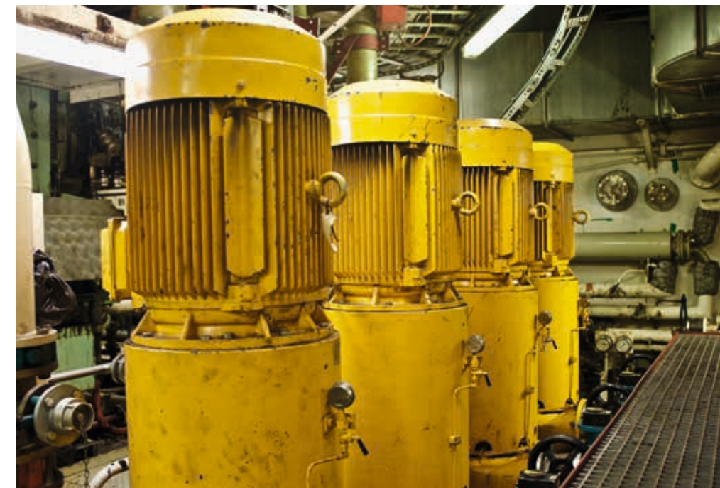
Pumpurnar umborð á Norrønu, sum pumpa sjógv upp í skrubbararnar. Nú ætla norsku myndugleikarnir at seta millum annað stórum reikferðaskipum forboð fyri at nýta skrubbarar inni á norskum firðunum av ótta fyri, at skrubbararnir dálka firðirnar
