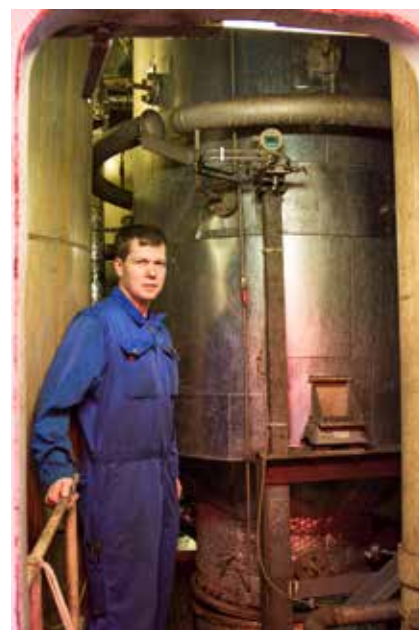
Poul Henning Poulsen, skipssførara-aspirantur stendur saman við skrubbaraútgerðini umborð á Norrønu. mynd: Rúni Olsen
