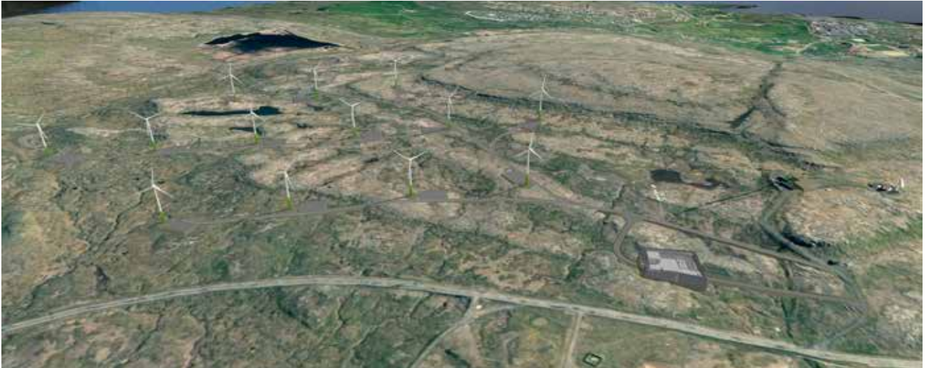
Koblings- og battarískipanin skal hýsast í svarta bygningin í vindmyllulundina í Húsahaganum.
