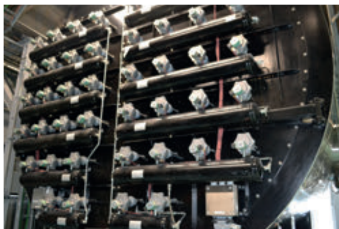
Dampketilin, har roykurin hitar dampin, sum síðani hitar tungoljuna
