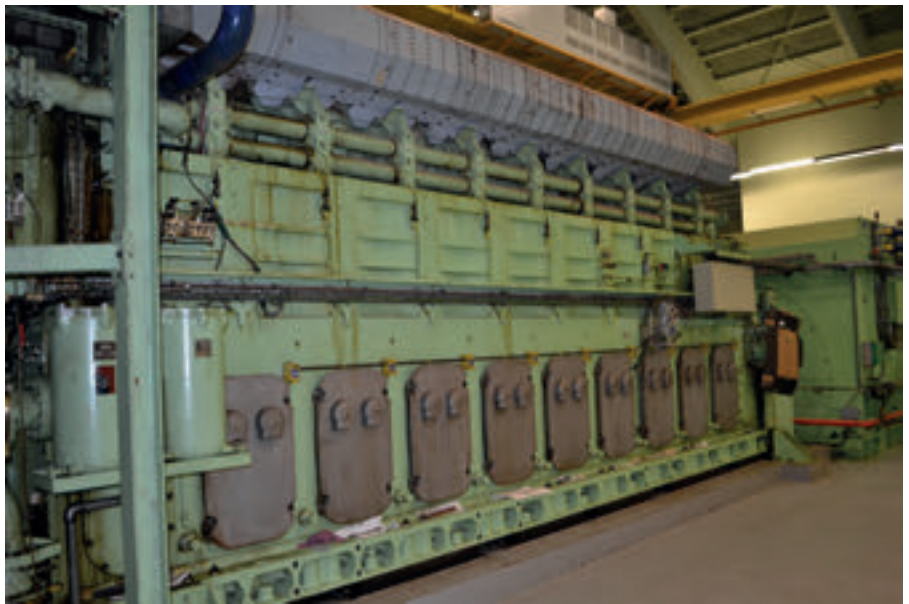
Í nýggju høllini eru fyra MAN-motorar, hvør upp á góð 9 MW
