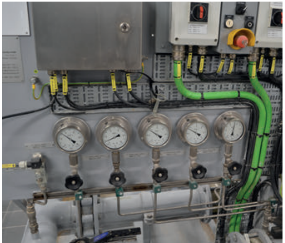
Kølivatnsmodulið á einum av nýggju MAN-motorunum
