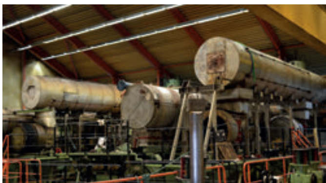
Elsti motorurin er frá 1983 og næstelsti er frá 1988, og báðir koyra enn. Teir eru 12 MW hvør
