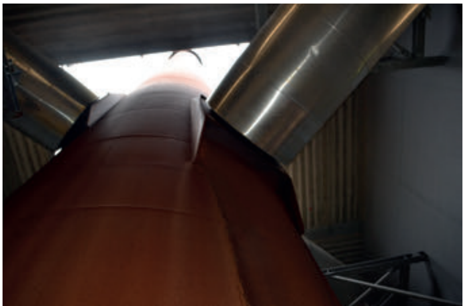
Skorsteinurin í nýggja verkinum stendur leysur mitt á bygninginum og býtur bygningin upp, so tað eru tveir motorar hvørju megin
